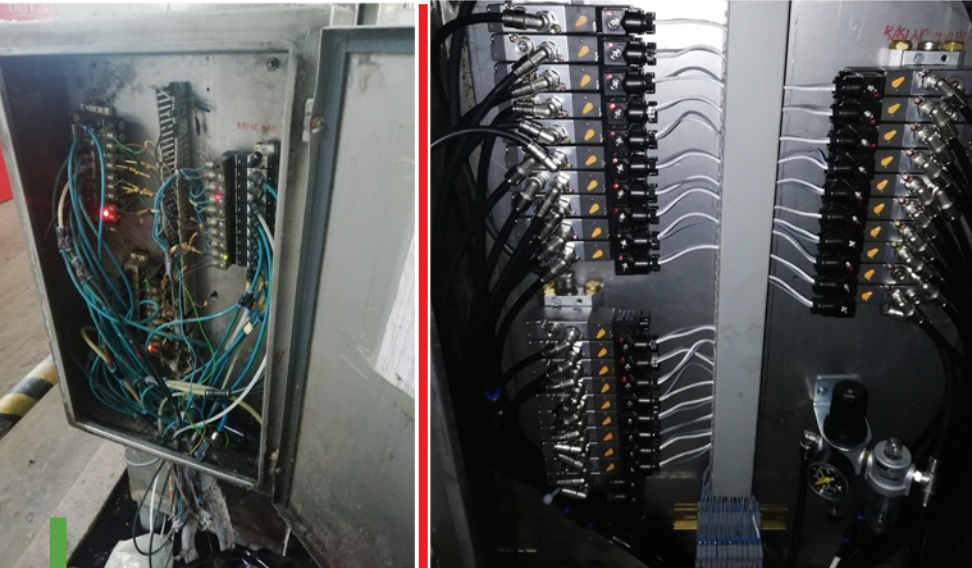
PNOMATİK TESİSAT REVİZYONU | PNEUMATIC INSTALLATION REVISION
